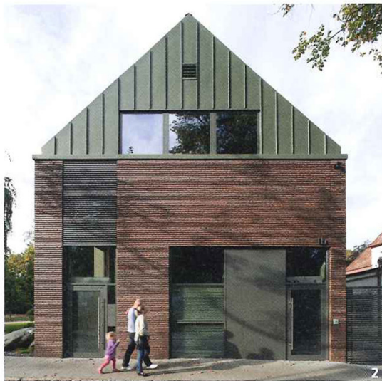
2 | Elewacja frontowa. Minimalistyczną bryłę wykończono rdzawoszarą cegłą i ciemnoszarą blachą tytanowocynkową. Po lewej wejście do pracowni, po prawej drzwi prowadzące do apartamentów na wynajem
